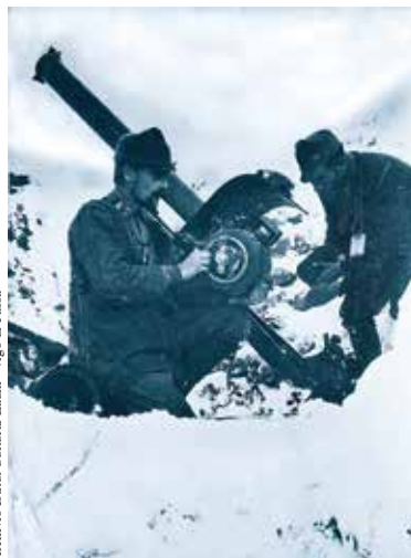
Baraccamenti austriaci ai piedi del Col de Bous, sperone roccioso posto sopra la zona del Fedaia. Bombarda austriaca contro le postazioni italiane.
